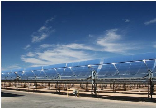
(a) Un concentrateur cylindro-parabolique. Source : site web de NextEra Energy Ressources (entreprise états-unienne)
