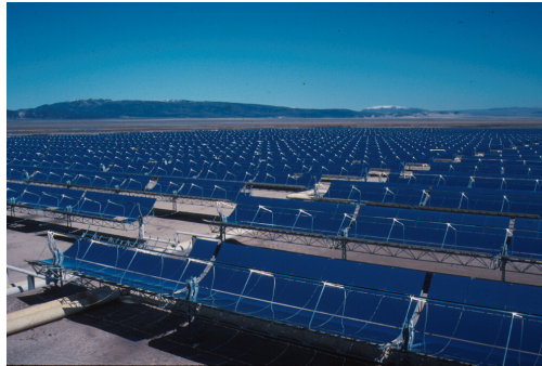
(d) Vue sur un des champs de concentrateurs cylindro-paraboliques du complexe SEGS, en Californie. Source : Wikimedia Commons
