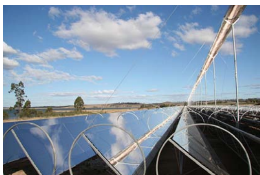
(c) Réflecteur linéaire de Fresnel à Liddell (Australie) : concentrateur linéaire à plusieurs miroirs
