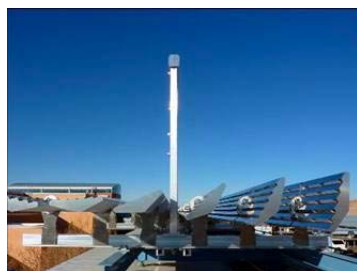
(a) HD16 pour application sur bâtiment ou industrie (10 ou 21 kW)
